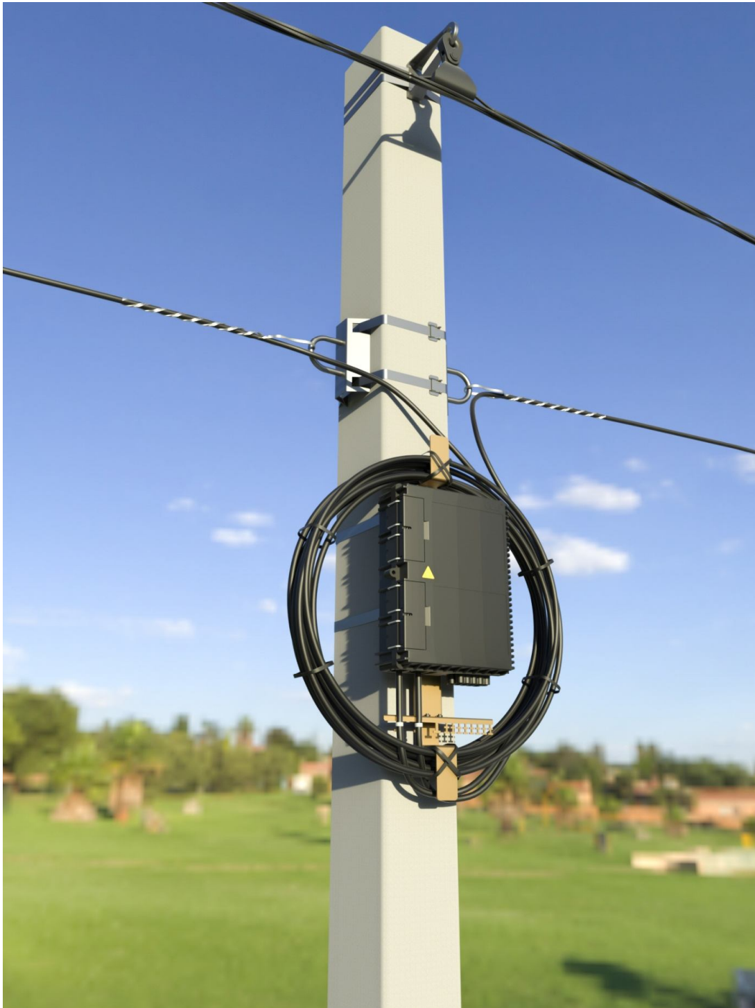
Рисунок 4. Закрепить кронштейн на опоре стальными нержавеющими хомутами.
