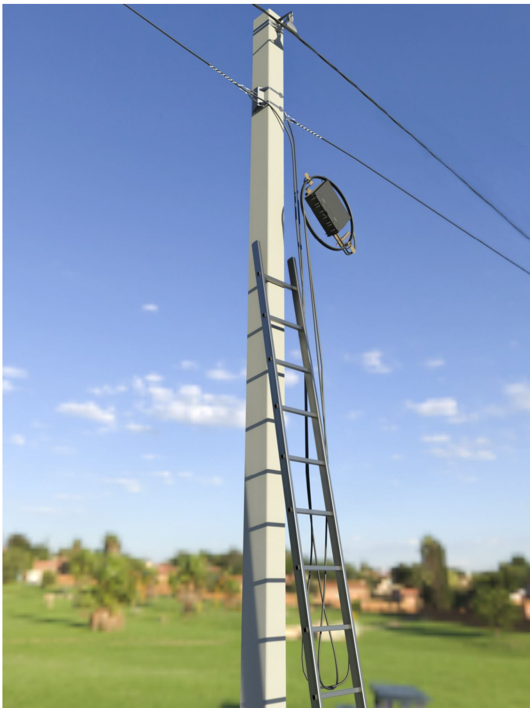
Рисунок 2. Находясь на лестнице наверху возле места крепления муфты, вращая кронштейн с муфтой, намотать кабели в плотное кольцо без просветов между витками.
