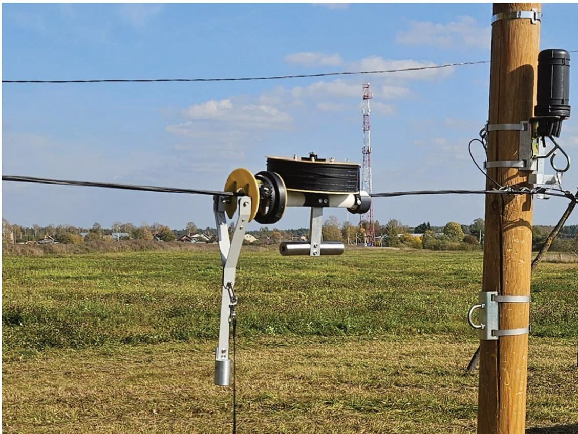
Навивочная машинка WF-330BF предназначена для монтажа тонкого волоконно-оптического кабеля методом навивки на несущий элемент с пластиковой оболочкой (диаметром до 24 мм) – ОКСН, СИП (2x16, 2x25, 4x16, 4x25 мм<sup>2</sup>), или диэлектрический трос. Также с помощью машинки для преобразования в одиночный кабель-жгут можно обмотать веерный пучок из нескольких волоконно-оптических кабелей тонким волоконно-оптическим кабелем или диэлектрическим кордом.
